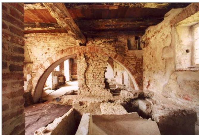
Restauro dell'arco e messa in luce delle vasche affioranti del corpo est foto di S. Fiorillo
