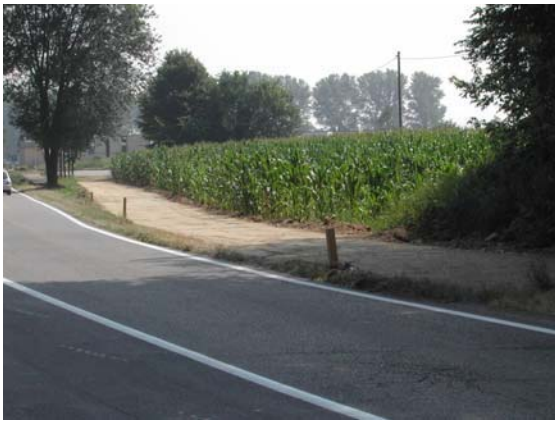
Tracciamento della pista che collega il municipio al cimitero, in Comune di Tribiano Foto di C. Boca
