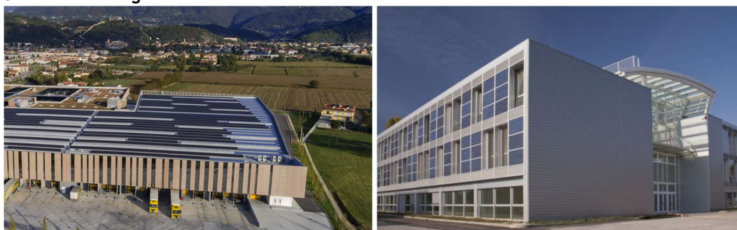
Facciata fotovoltaica, polo tecnologico di Lucca, IT e Pannelli solari sul nuovo Polo Logistico di Vimar a Marostica, IT
