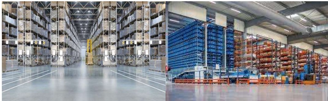
Esempi di magazzini di stoccaggio
