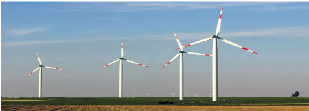
Impianto eolico, Pontedera, IT
