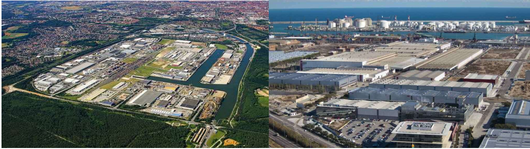
Centro logistico di Norimberga “Bayernhafen Nurnberg” (a sinistra) e Puerto Seco de Madrid (a destra)
